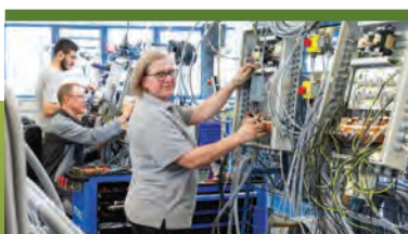
Verteiler- und Schaltschrankbau
